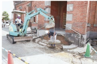
階段石取り外し作業
